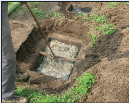
Il y a trop d'écume. Il est temps de pomper votre fosse et d'inspecter votre champ d'épuration
